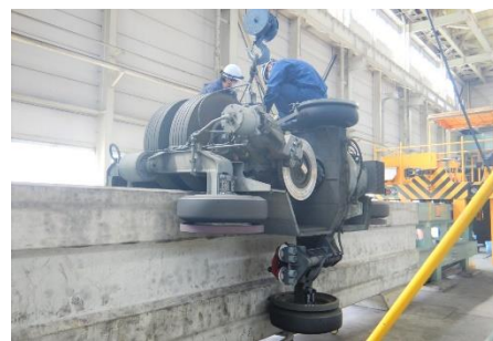
②台車吊り上げ
